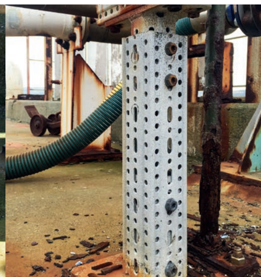
Po šestih letih izpostavitve okoljskim vplivom – Offshore (CX)
