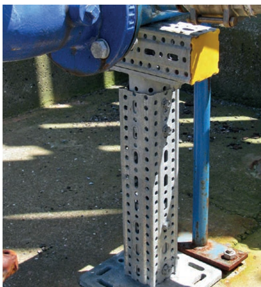
Konvencionalni T-podporniki in siFramo 80 nekaj mesecev po montaži
