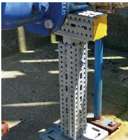
Konvencionalni T-nosači i siFramo 80 profil nekoliko mjeseci nakon montaže
